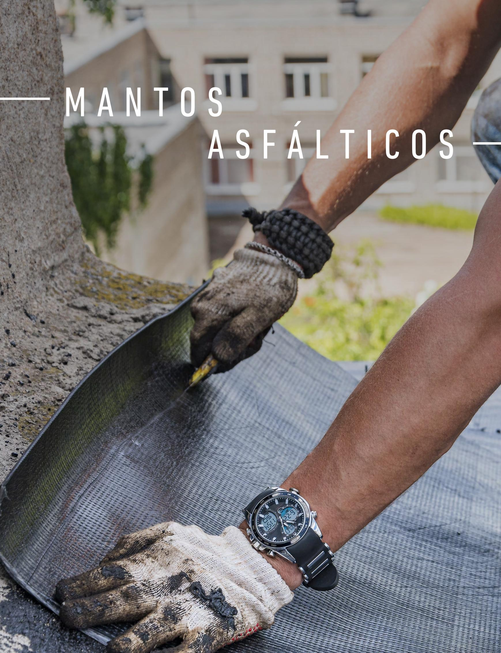
Ofrecemos soluciones duraderas para impermeabilización en frío. Fabricados con compuestos bituminosos de alta calidad y refuerzo en poliéster, son ideales para sistemas de una o doble capa en techos, terrazas y superficies de concreto, brindando protección efectiva frente al agua y al desgaste.
