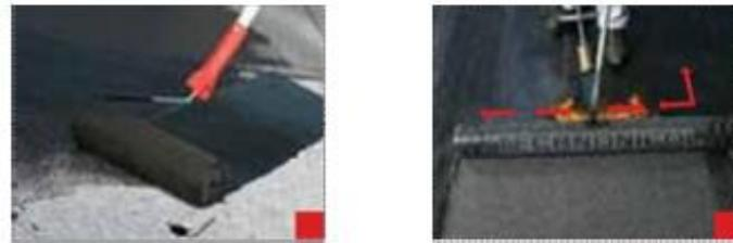
La superficie debe estar limpia de polvo, escombros, grasa, hojas, sin agujeros, grietas u otras irregularidades. La superficie debe estar tratada con imprimación antes de la instalación del material impermeabilizante.
